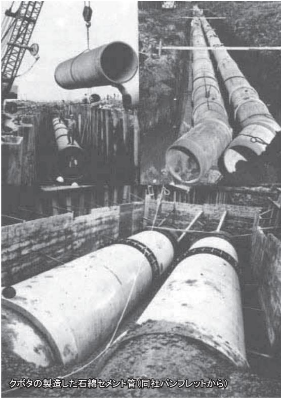
クボタの製造した石綿セメント管(同社パンフレットから)
