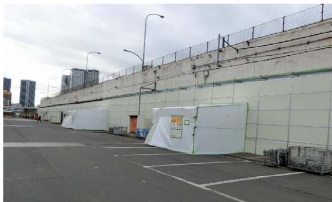
さないように、養生内で負圧除じん機を稼働させて、負圧除じん機に設置されたHEPAフィルターにアスベスト粉じんを吸着させる。さらに、この養生内への出入りには、作業者はセキュリティルームと呼ばれる3室を通って入り、その中で汚染された保護服を脱いで出てくることになる。
