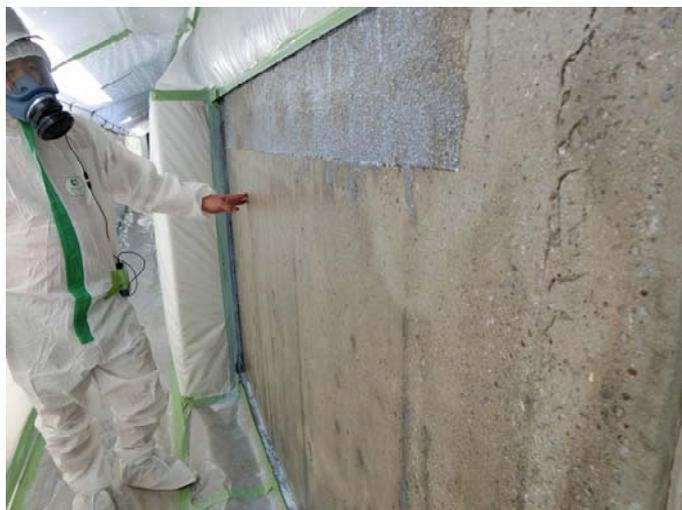
ところが、築地での検査を終わり事務所に戻ったところ、検査に同行したEFAラボラトリーズのメンバーから電話があり、事前のアスベスト調査表を再度見たら、塗材の表層がアスベスト含有ではなく、下地材にアスベスト含有と表記されていると指摘を受けた。あわてて築地市場の管理会社に電話して、今日の完了検査した塗材はアスベストが残ったままなので、養生を解体する前に全部撤去のやり直しを指示した。その際下地材の下のコンクリートの肌地が見えるまで表層を削るように、また、削った後を再検査することを話した。
