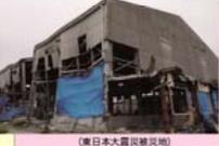
波板スレートなどのセメント板は、大量に製造されたアスベスト含有製品で、未だ大量に私たちのまわりに残されています。通常の使用では飛散しませんが、災害時には粉碎され、危険な状態になります。
