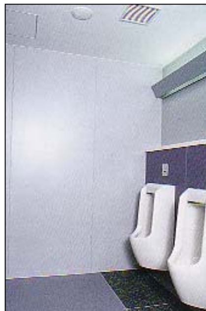
写真 3.9 ビルトイレの壁及び天井
