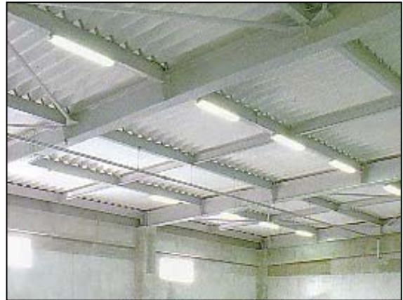
写真 3.11 体育館折版屋根裏
