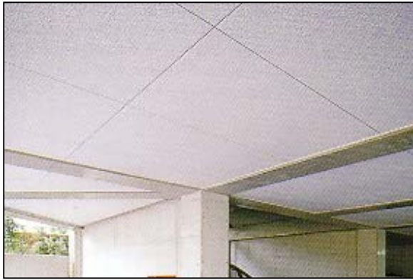
写真 3.10 駐車場の天井
