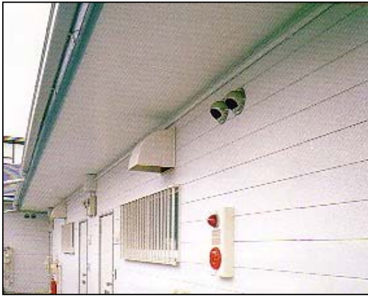
写真 3.1 一般住宅外壁
