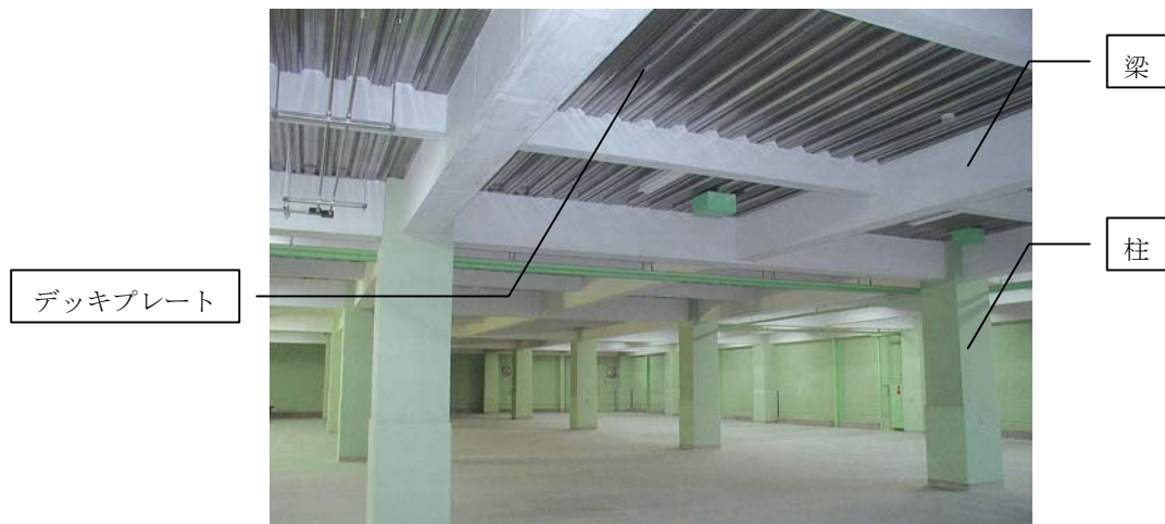
写真 3.3 けい酸カルシウム板第2種を施工した梁・柱及びデッキプレート
