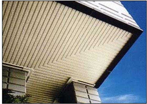
写真 3.2 一般住宅軒天
