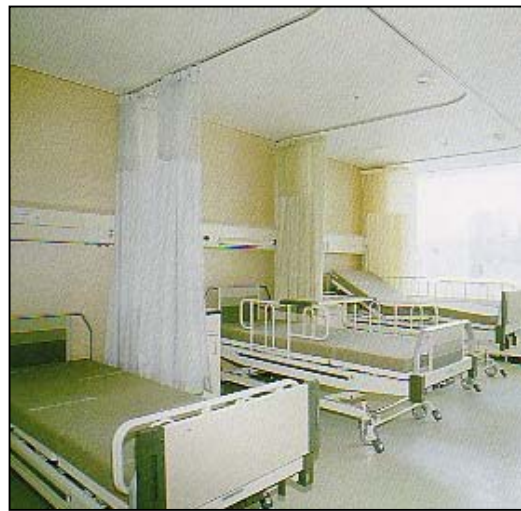
写真 3.7 病院の壁及び天井
