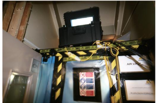
写真6: シェフィールドの除去現場の入口。監視用のCCTVが入口の上にある。
