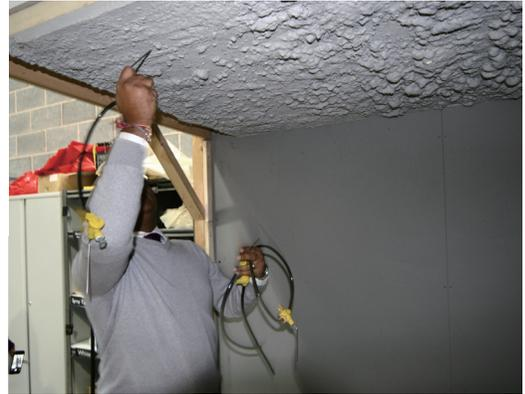
写真5: ARCAの研修施設にて。模擬吹付けクロソライトを湿潤化する練習。
