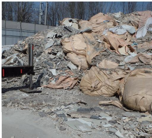
写真5：仮置場で見られた細かく破砕されたスレート板
