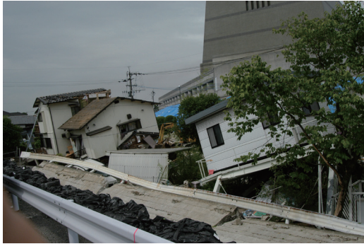
益城町役場ちかくの倒壊家屋
