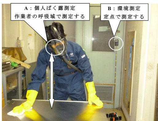
図8 ブランケットの拭き取り作業
