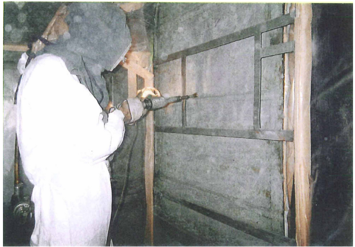
JR車輛アスベスト除去作業（裁判書証より）
