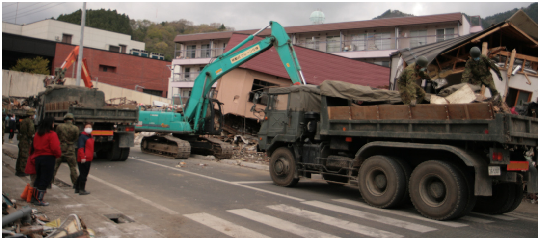
被災地ではがれきの除去作業がよいよ本格化する（5月4日 釜石市内）
