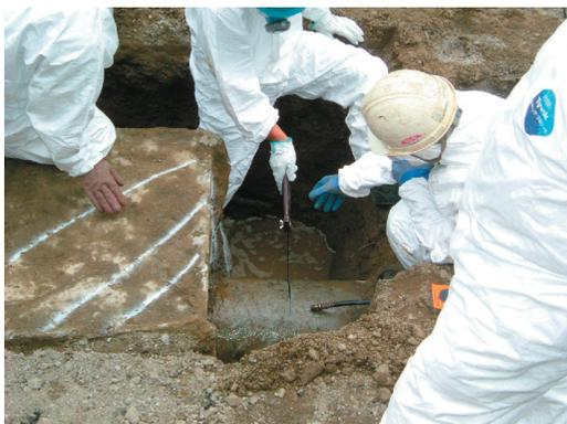
① 実際のアスベスト管撤去の様子(2003年7月、墨田区)
