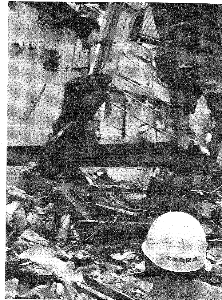
鉄骨を持ち上げ吹き付けられたアスベストを振り落としている
