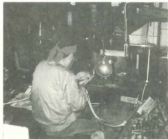
図3 「フレクション」に設置された安全装置
