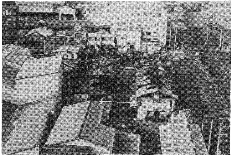
再び増加傾向示す死亡災害 東京・第一化成爆発現場(6/6撮影)
